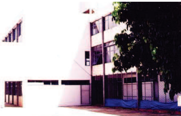
CEFAK - Vista do pátio interno
